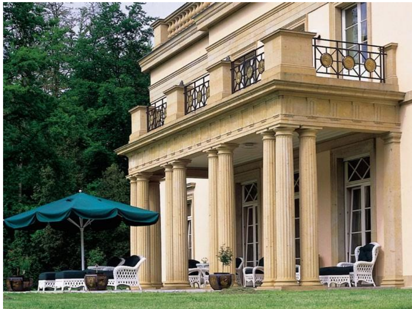
REINHARDTSDORFER SANDSTEIN, chalet privado, Fráncfort del Meno
