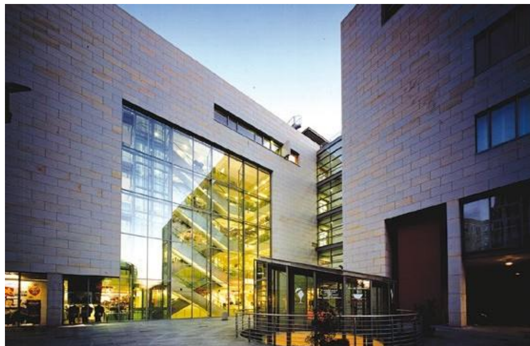
COTTAER SANDSTEIN-gwg- Obchodní domy Wöhrl, Prager Straße Draždany
